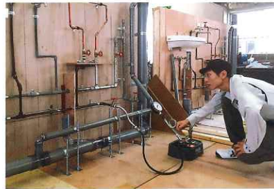
校内には、配管施工の技能を身につけ、高められる充実した実習環境が完備されています。
