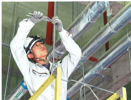
母校である仙台校の改修工事に携われることに、喜びを感じながら作業にあたる山崎さん。
